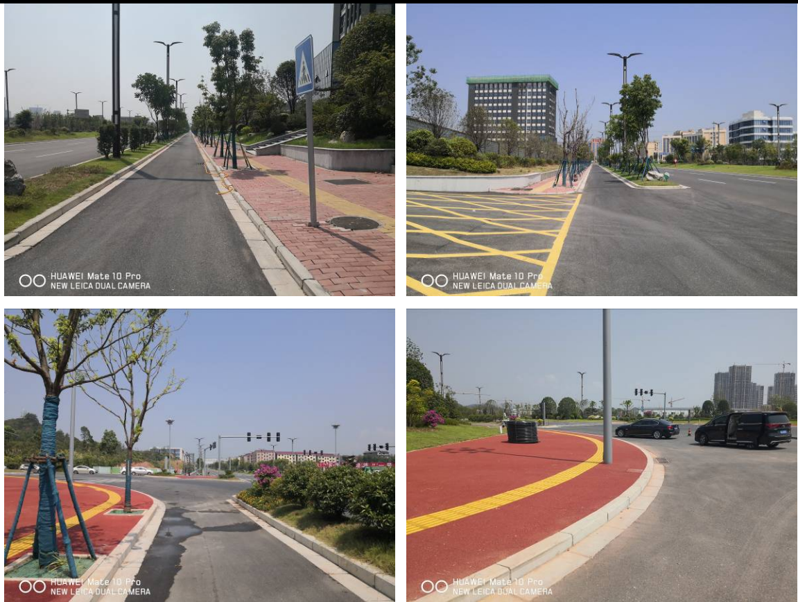
图 2-6 本工程电缆线路沿线现状情况照片
