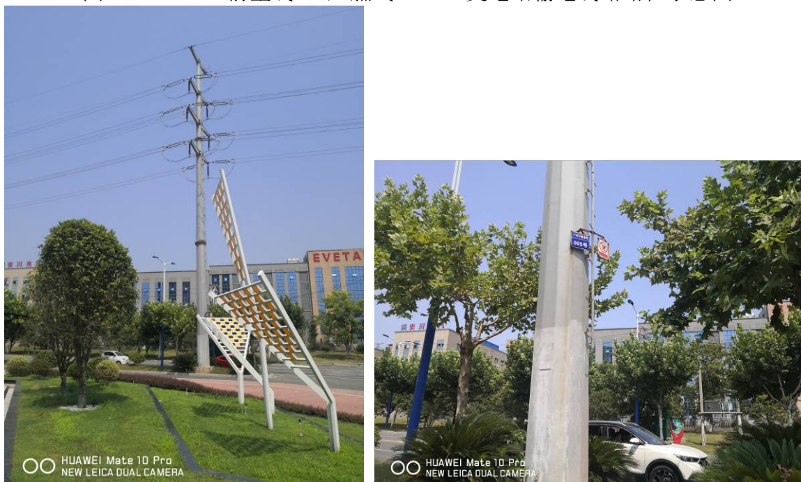
图 2-4 本工程 110kV 前董线#5 破口点现状照片
