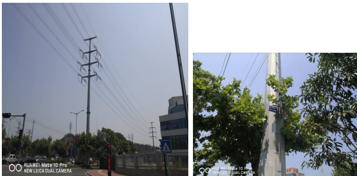
图 2-5 本工程 110kV 前董线#4 破口点现状照片
