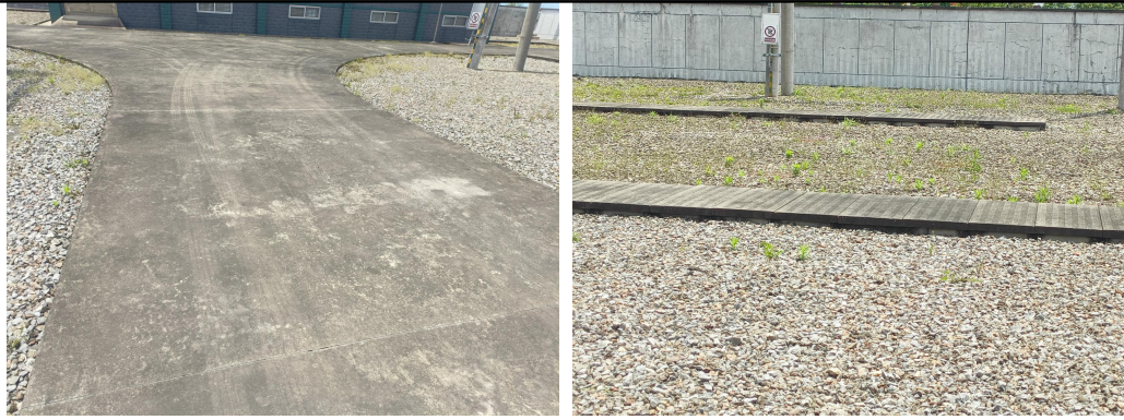
站内硬化道路
